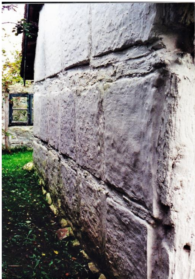
Vestgavlen med det tætte bindingsværk
