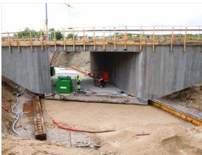
Dellinge. Den nye viadukt skubbes på plads
