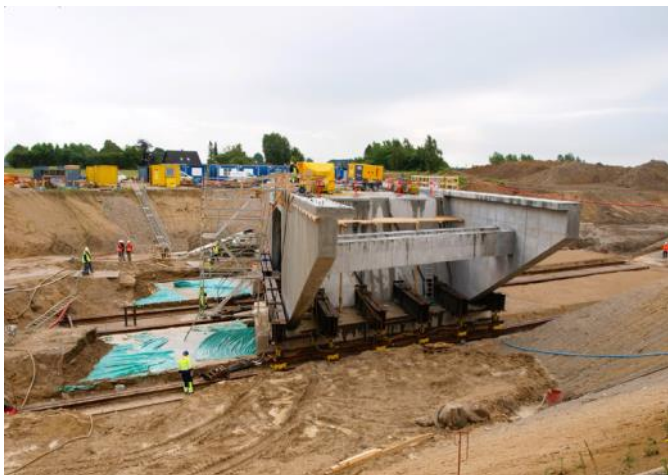
Soderup. Den nye viadukt skubbes på plads
