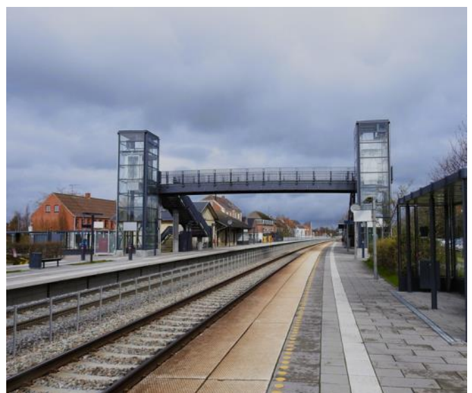
Tølløse station med elevatorer
